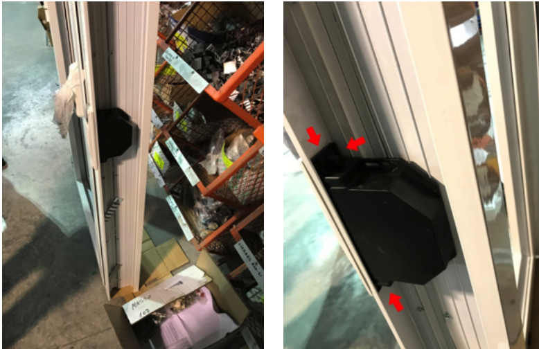
Figura 67. Detalle de guía para embutir el recogedor indicando zonas a sellar
