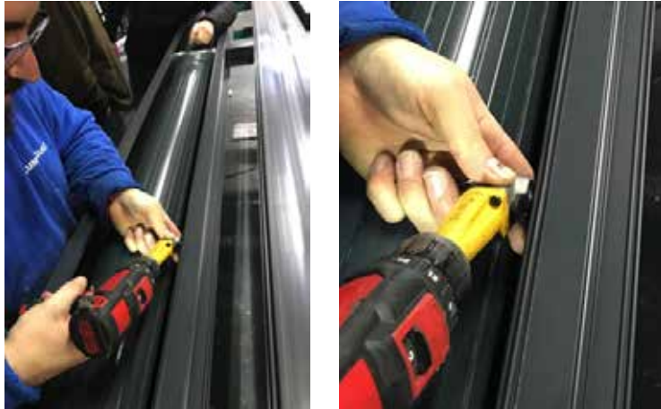
Figura 61. Atornillado del cajón a la ventana
