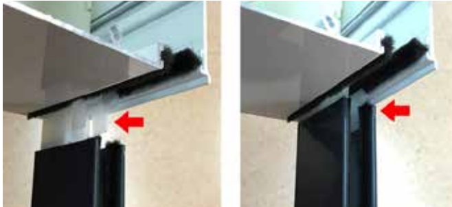
Figura 59. Unión ventana cajón
