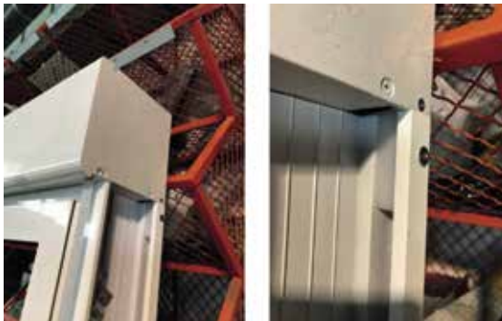
Figura 60. Embudo introducido en guía, con atornillado lateral
